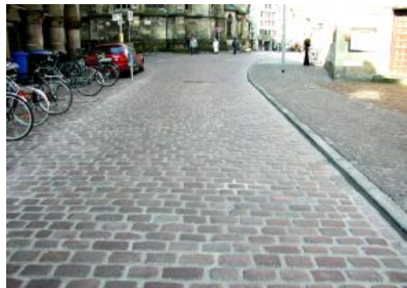
6. Fertig verfugte Fläche
