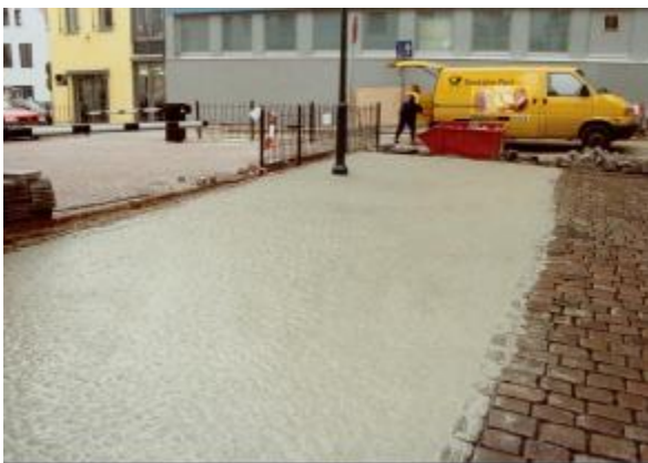
3. Fertig eingeschlämmte Fläche
