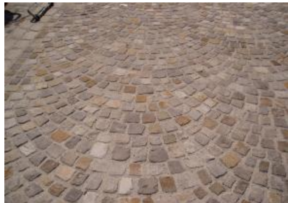
5. Fertige verfugte Fläche
