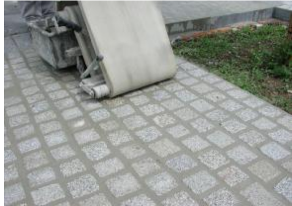
4. Reinigung mit Schwammputzmaschine
