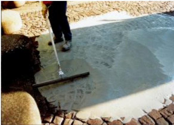
2. RSB PFM einschlämmen
