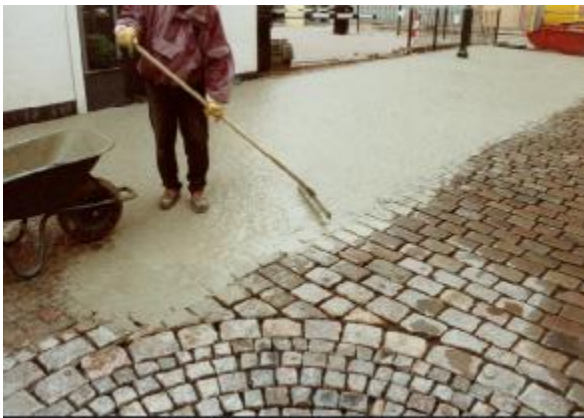
2. RSB PFM einschlämmen
