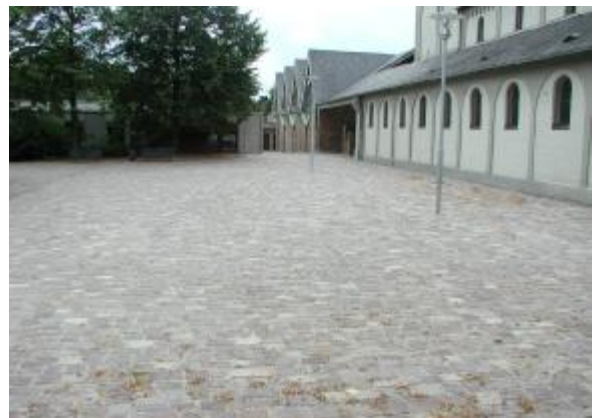
5. Fertige verfugte Fläche
