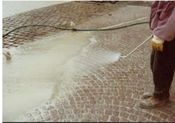
4. Reinigung mit RSB Fächerdüse
