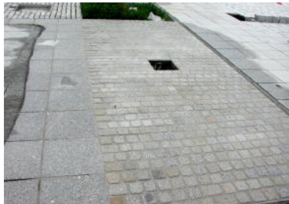
5. Fertig verfugte Fläche
