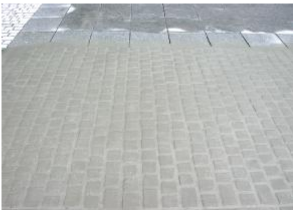
3. Fertig eingeschlämmte Fläche
