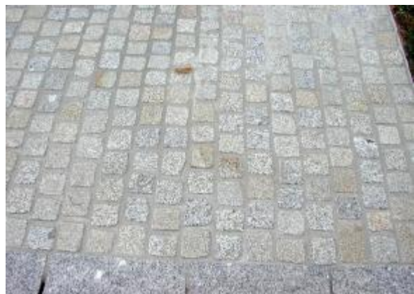
5. Fertig verfugte Fläche
