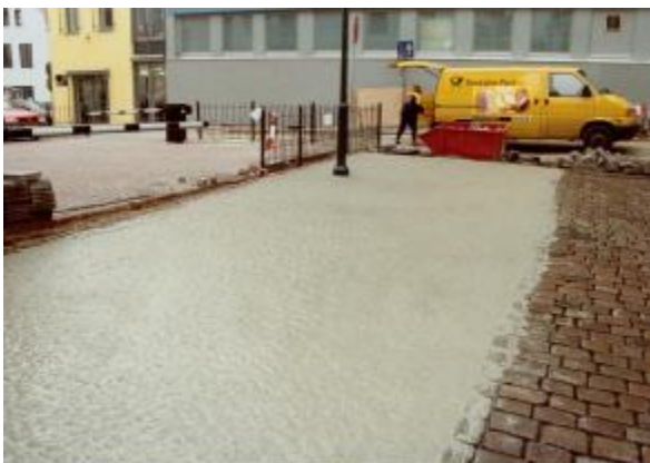
3. Fertig eingeschlänmte Fläche
