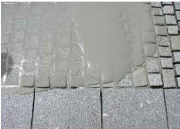
2. RSB PFM einschlämmen
