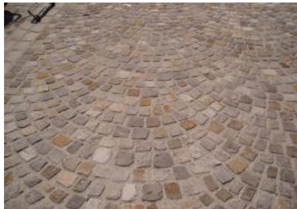
5. Fertige verfugte Fläche
