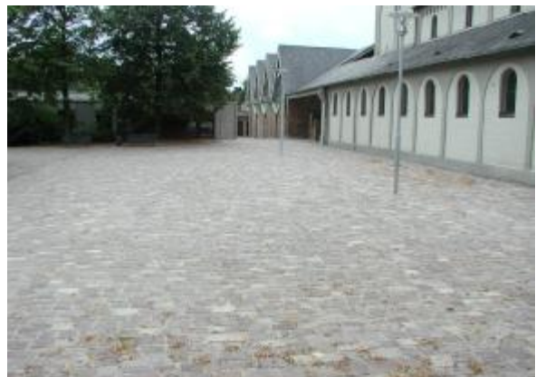
5. Fertige verfugte Fläche
