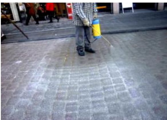
3. Fläche mit RS einsprühen
